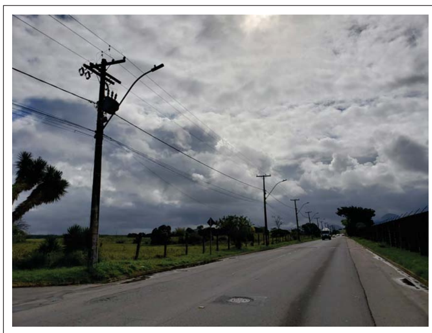
figura 14. - Infra Estrutura - iluminação publica e rede elétrica / telefone
