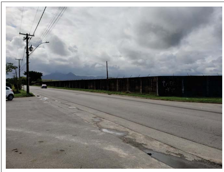
figura 11. - Infra Estrutura - pavimentação
