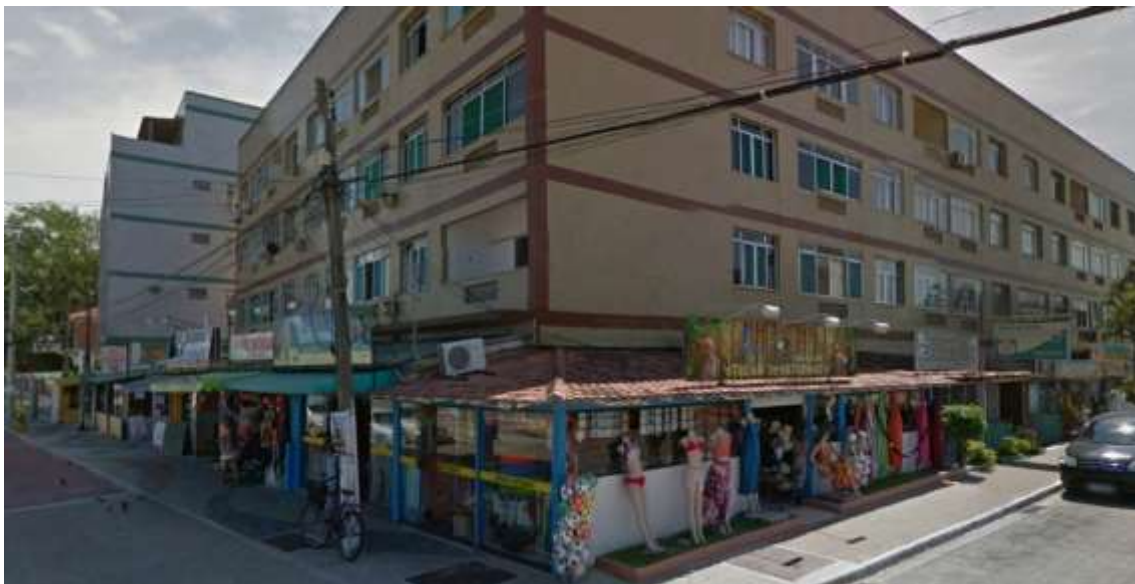
Foto 2 – Av. Beira Mar vizinhança mediata composta por comercio e residências. Fonte: Google Earth Pro 2018.
